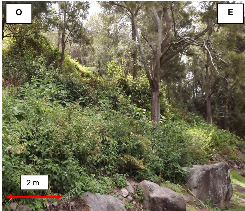
Figure 35 : Versant ouest dominant la partie sud du village d'Aurère
