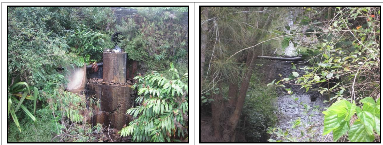
Figure 43 : Vue des prises Prudent 1 (gauche) et Prudent 2 (droite).
