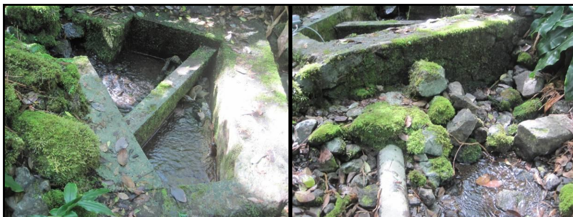
Figure 39 : Vue du seuil de captage Avalasse
