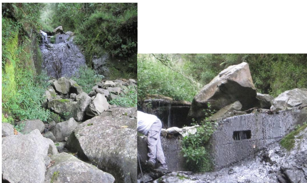
Figure 29 : Vues générales du captage Le Cœur.
