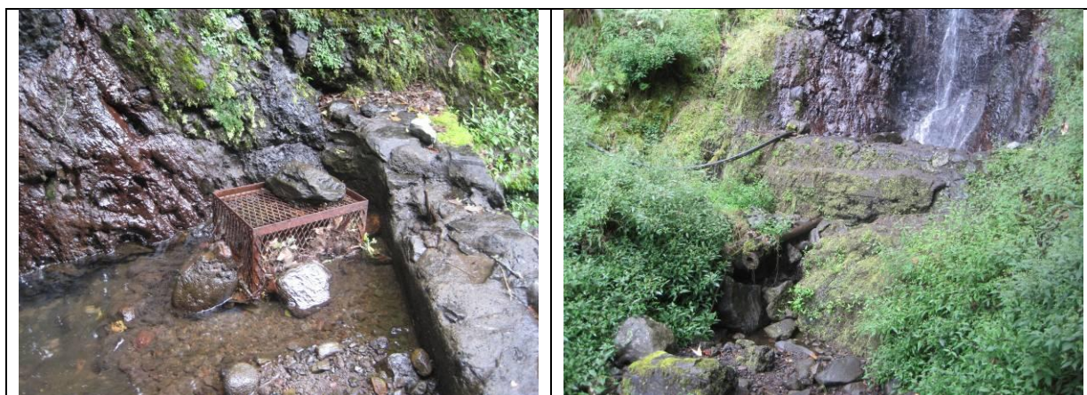
Figure 27 : Vues générales du captage de Bras Morel.
