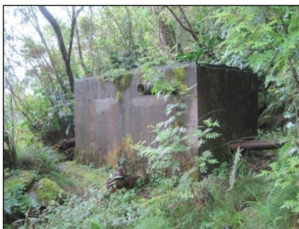
Figure 8 : Photo du bassin (dessableur)
