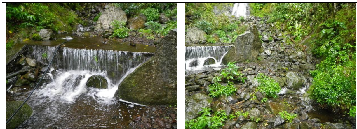
Figure 32 : Vues du seuil du captage Kerveguen (gauche) et du bras de contournement en rive gauche (droite).
