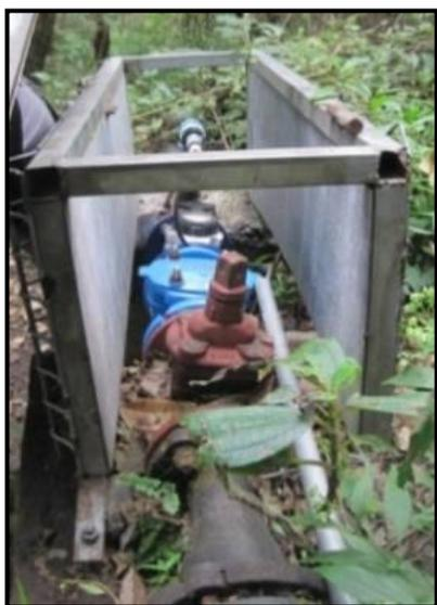
Sur une des canalisations, une chloration en ligne est effectuée pour l'alimentation en eau potable d'Ilet à Calebasses.
