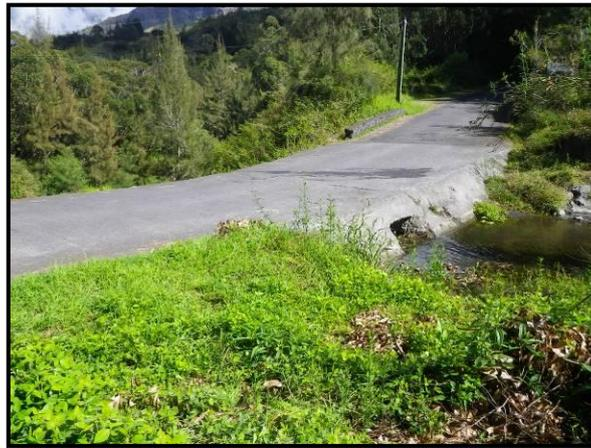
Figure 22 : Vue du radier routier sur le Bras des Calumets au niveau de la route d'Ilet à Calebasses.
