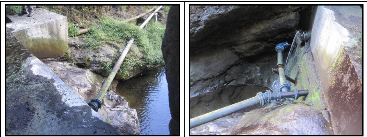
Figure 26 : Vues du seuil du captage du Bras de la Vierge.
