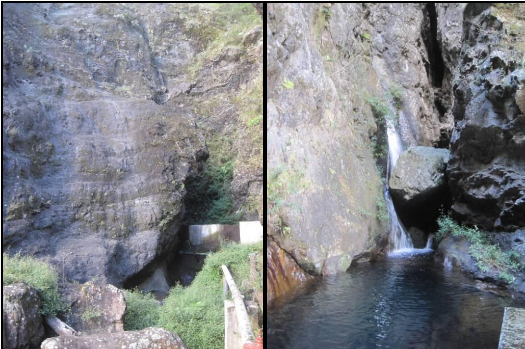
Figure 25 : Vues de la configuration du cours d'eau en amont du captage du Bras de la Vierge.
