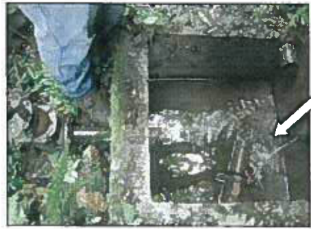
Captage C1 (vue de la conduite drainant la roche et de la bache de captage fermée (gauche) et ouverte (droite))
