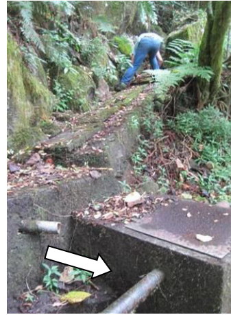
Vue du canal (haut de la photo) et de l'ouvrage de réception
