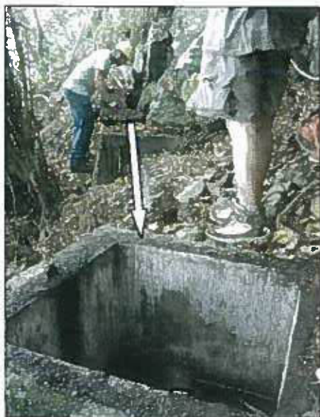
Captage C4 : rigole et bâche de réception
