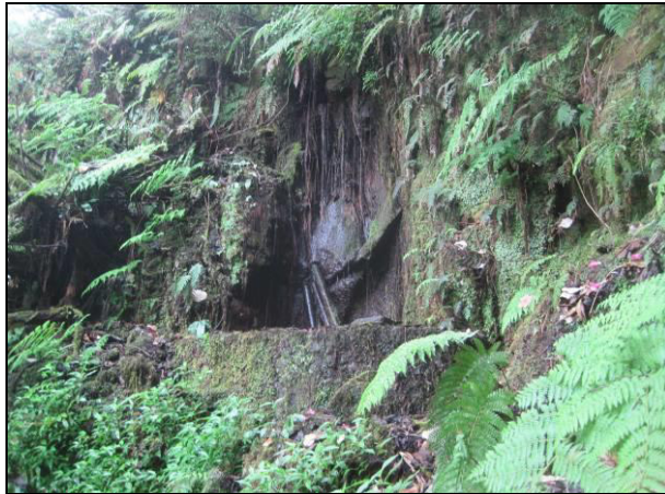
Captage C2 (vue des émergences à flanc de rempart et de la bache de captage)
