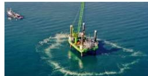
Dans le cas d'espèce, un rideau à bulles pourra être installé au droit de la passe d'entrée du port (linéaire de 15 mètres) afin d'assurer une barrière vis-à-vis des travaux de dragage et de battage de pieux réalisés à l'intérieur du bassin. Cette barrière ne perturbe pas la circulation des bateaux.
