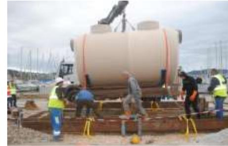
Les eaux de ruissellement feront également l'objet d'un traitement préalable par séparateur à hydrocarbures afin de prélever les éventuelles fractions huileuses.
