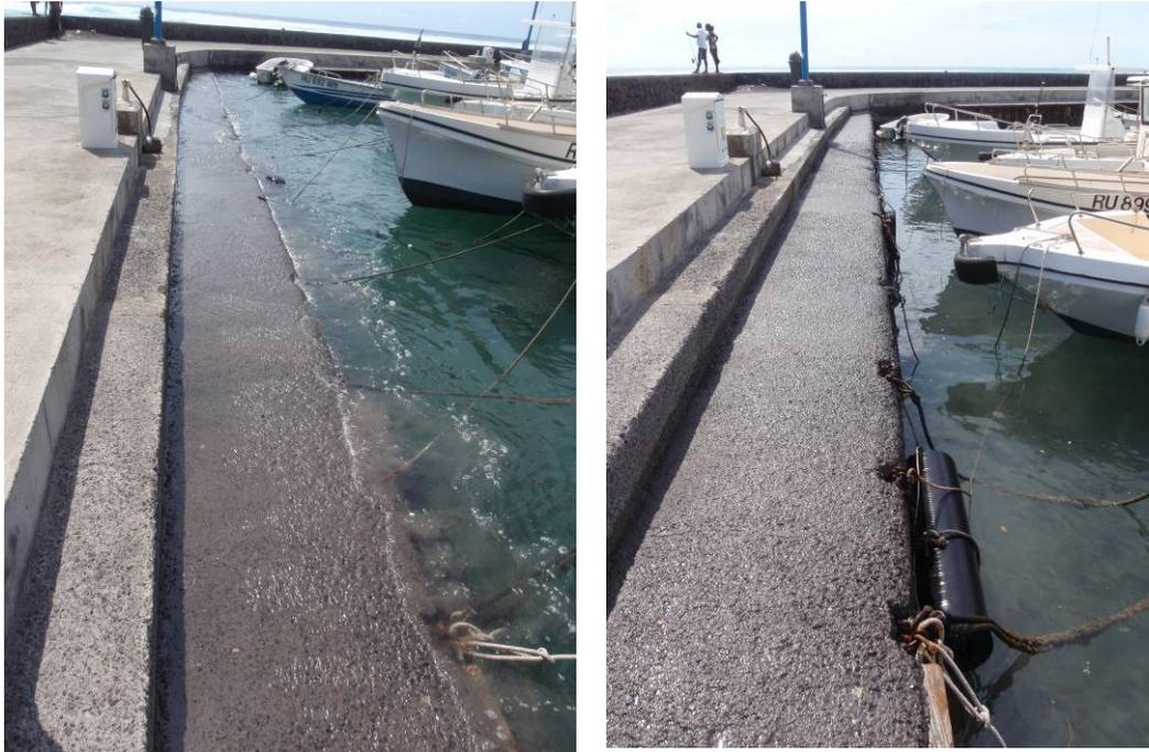
Figure 8 : Oscillation du plan d’eau portuaire liée aux variations du niveau d’eau dans le lagon en cas de fortes houles
