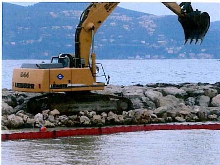
Issu de la technologie du barrage antipollution, le Barrage Travaux Maritimes est une barrière souple destinée à limiter l'envahissement des eaux portuaires des déchets de chantier (poussières, gravillons, macro déchets flottants, mousses d'écume diverses, sacs plastiques et déchets naviguant entre deux eaux...).
