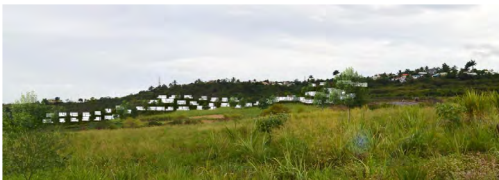
Figure 94 – Perceptions du projet et modification paysagère : inscription dans la pente et la trame végétale (Source : Atelier LD)
