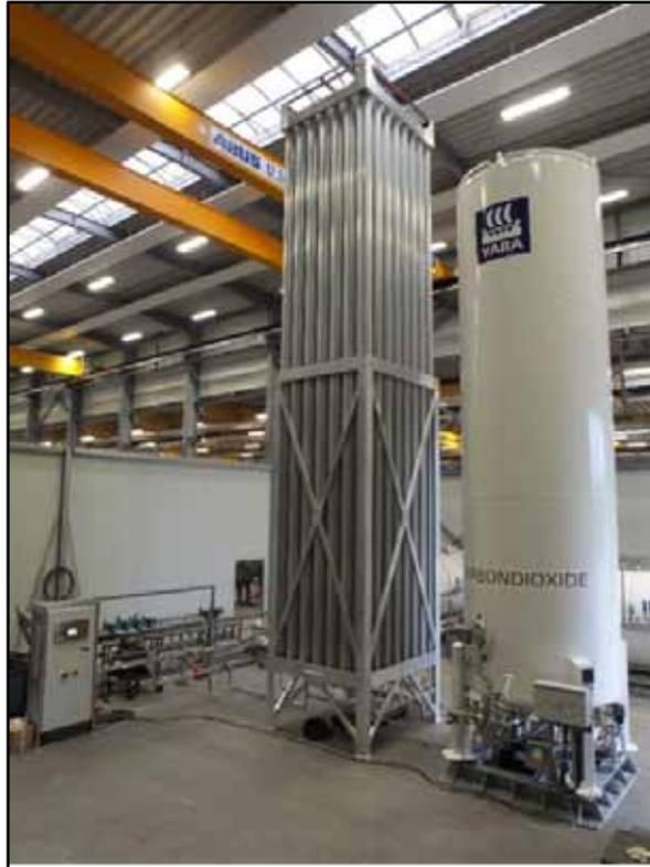
Planche 30 : Exemple de cuve de stockage d'azote liquide
