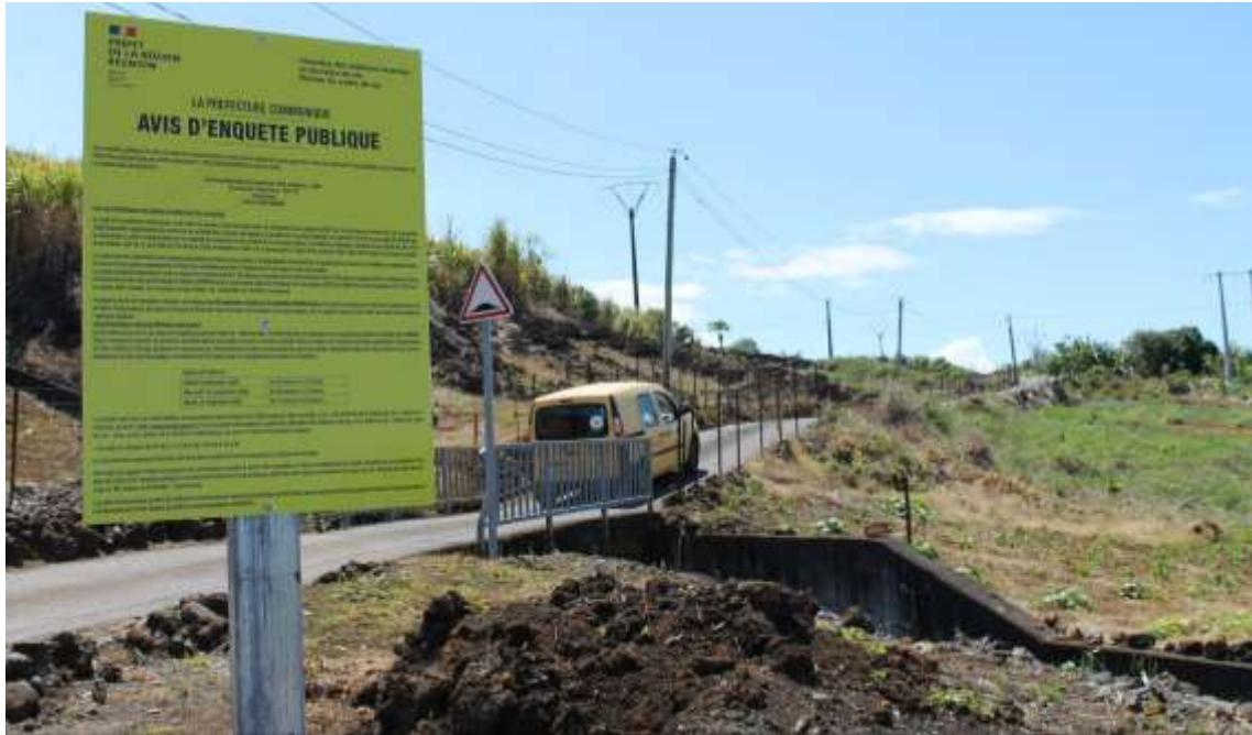
Panneau A2 situé sur le CD31 à l'entrée de l'allée des Pâquerettes.
