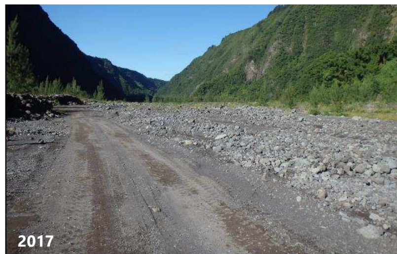
Accumulation de matériaux sur la zone de restauration du secteur des fosses : redistribution d'une partie des blocs mis en refus au sein du lit vif de la rivière des Remparts. L'axe d'écoulement préférentiel a très peu évolué entre 2017 et 2019.
