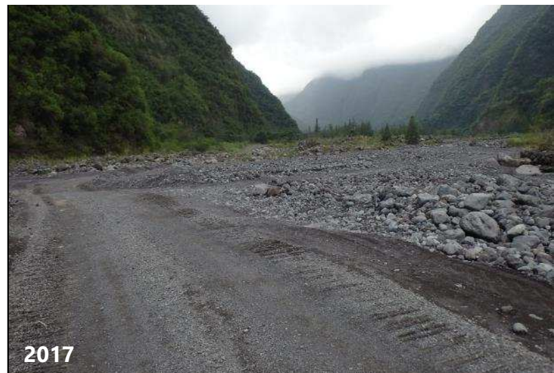
Accumulation de matériaux sur la zone de restauration du secteur des fosses : redistribution d'une partie des blocs mis en refus au sein du lit vif de la rivière des Remparts. L'axe d'écoulement préférentiel a très peu évolué entre 2017 et 2019.
