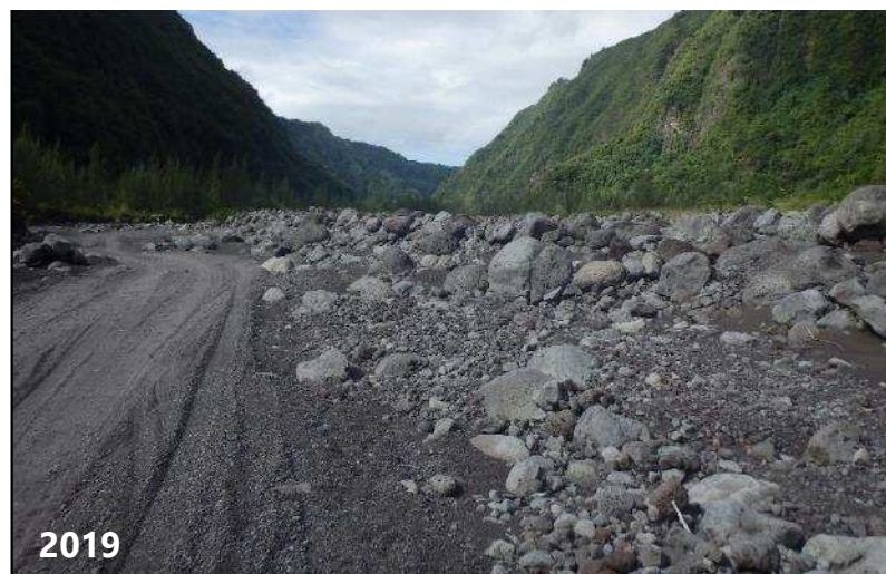
Accumulation de matériaux sur la zone de restauration du secteur des fosses : redistribution d'une partie des blocs mis en refus au sein du lit vif de la rivière des Remparts. L'axe d'écoulement préférentiel a très peu évolué entre 2017 et 2019.
