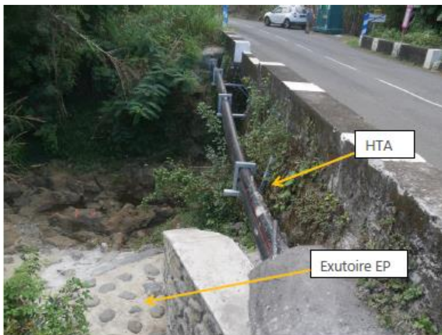
Figure 14 : Ouvrage de passage de la ravine du Pont, encorbellement existant (PRO SCP 2019)
