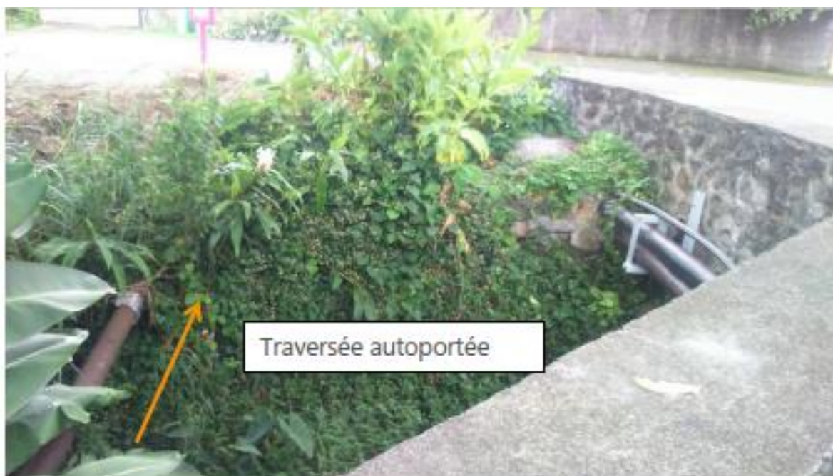
Figure 11 : Traversée du bras de la ravine du Pont, passage en autoporté existant (PRO SCP 2019)
