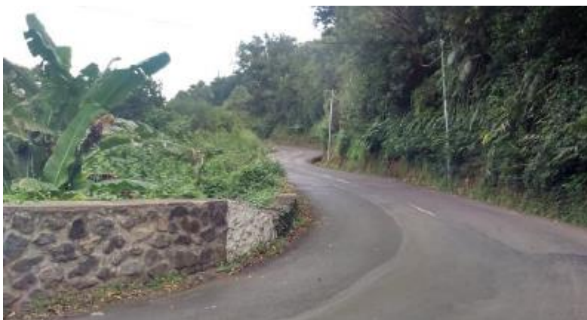
Figure 12 : Ouvrage de passage de l'affluent de la ravine de l'Anse, (PRO SCP 2019)
