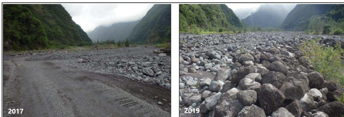
Figure 16 : Accumulation de matériaux sur la zone de restauration du secteur des fosses : redistribution d'une partie des blocs mis en refus au sein du lit vif de la rivière des Remparts.
