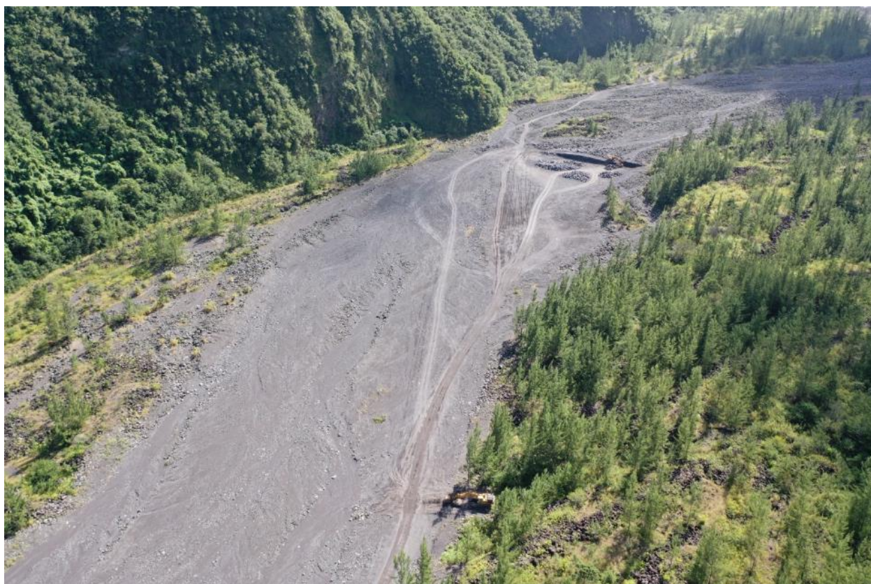
Figure 9: Illustrations de l'avancement des travaux sur la phase 1 déjà autorisée (Source : SCPR/Hydrétudes 2020)
