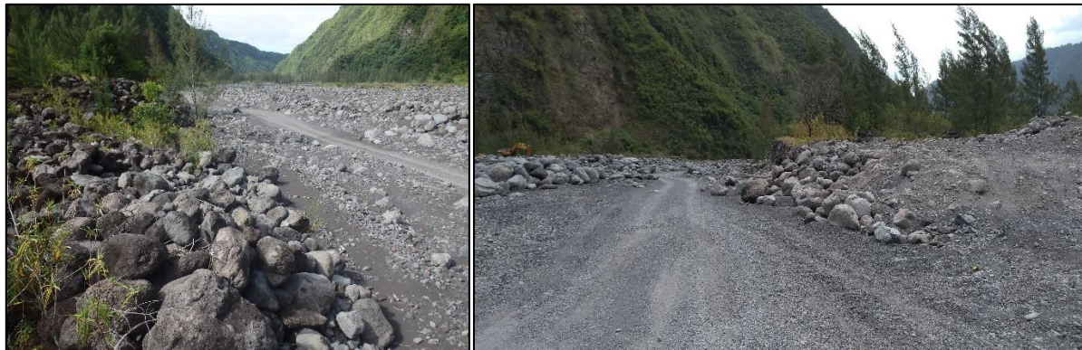
Figure 13 : Vues de la zone de remise en état (phase 1) avant et pendant les travaux de curage
