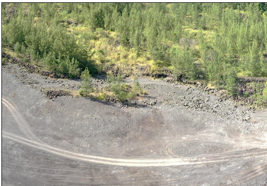
Figure 14 : Vues de la phase de remise en état sur la phase 1 déjà autorisée après curage en vue au sol et aérienne
