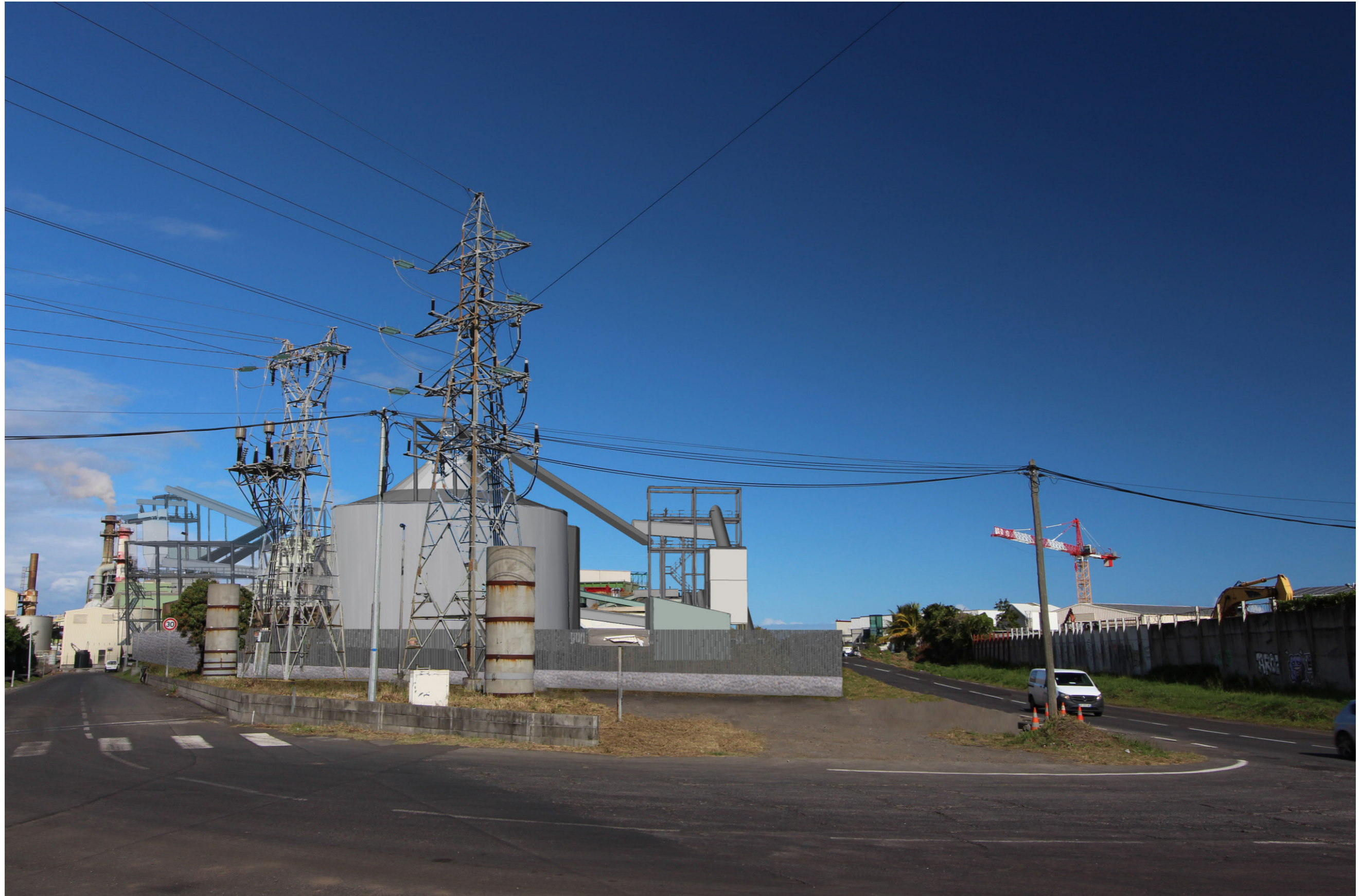
Vue depuis la Nationale 1, après implantation des silos et du bâtiment de stockage de biomasse
