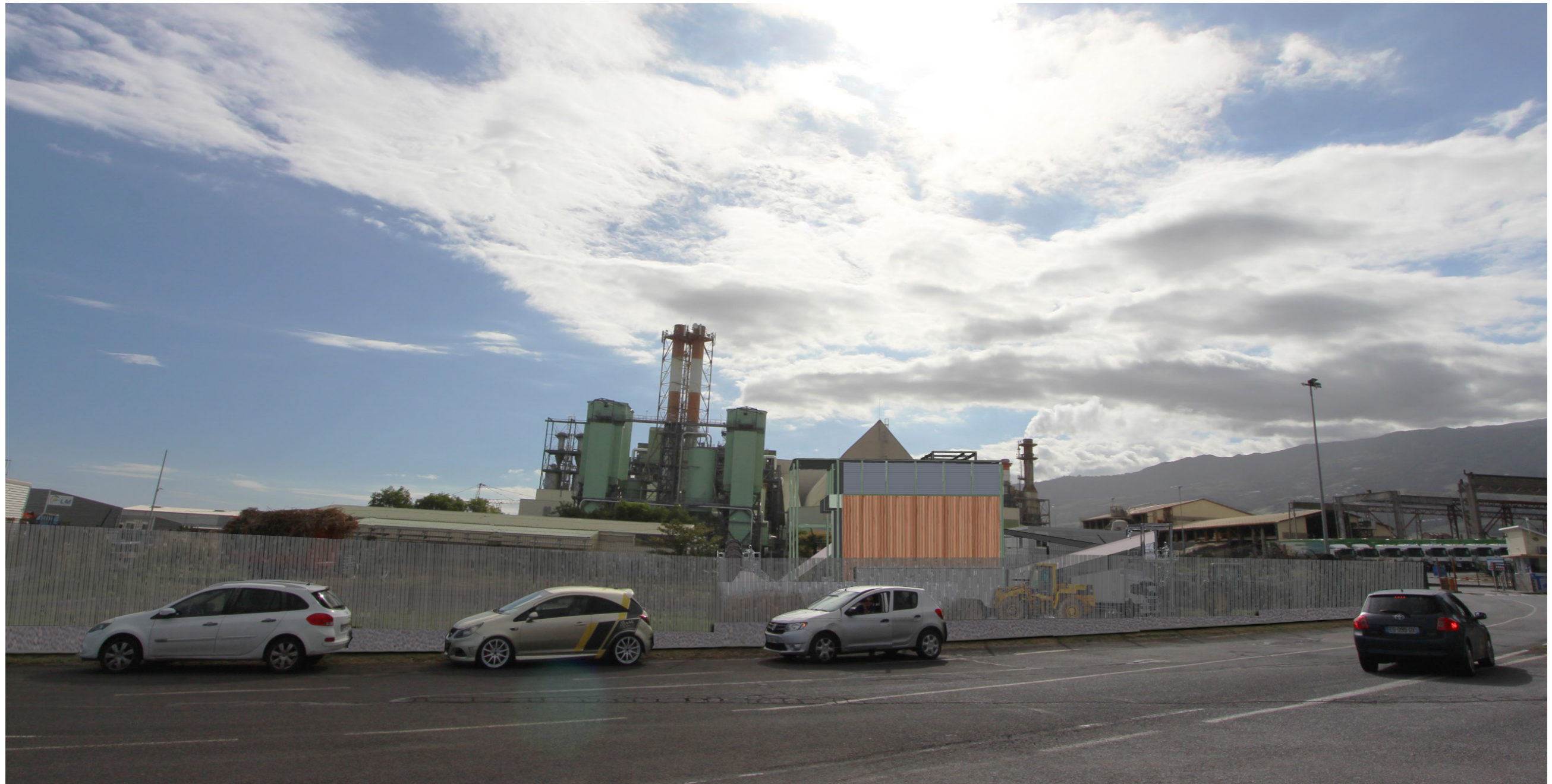
Insertion du bâtiment de stockage de biomasse
