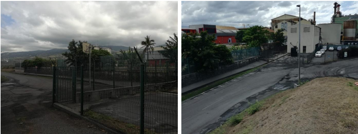
Figure 16: Muret de délimitation du site de TEREOS
