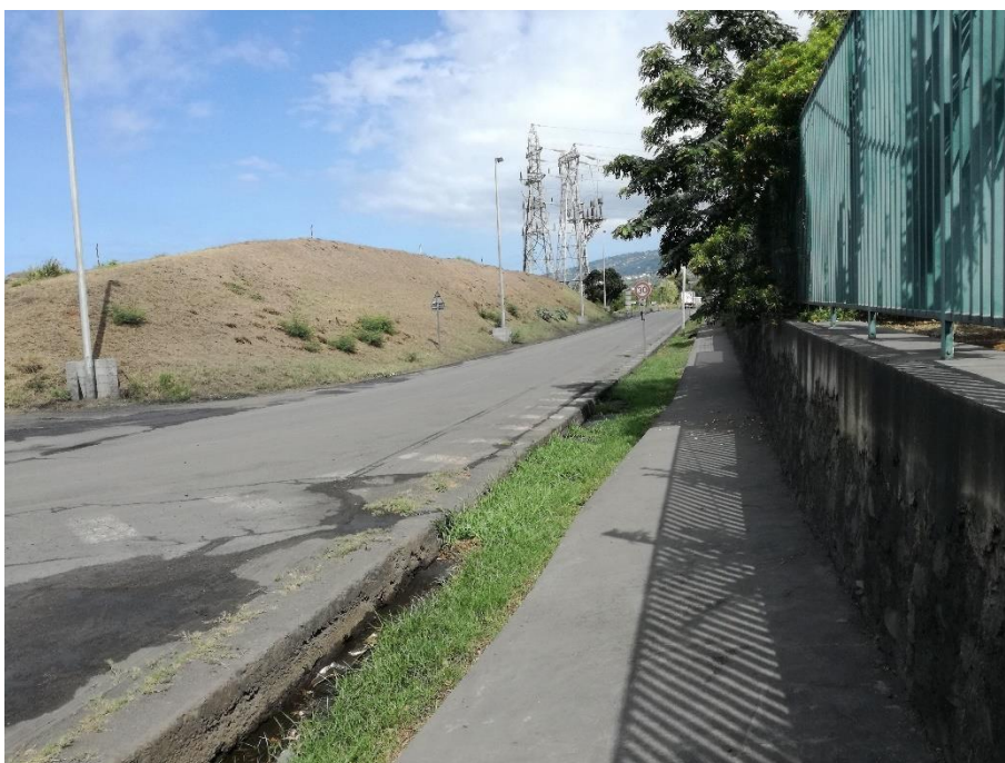
Figure 19: Merlon de ceinture et route d'accès au site
