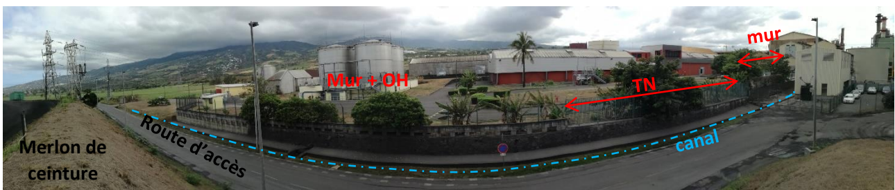
Figure 17: Mur au sud de la distillerie
