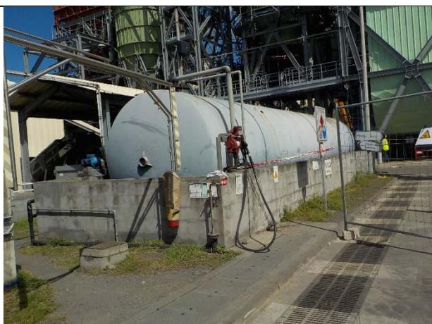
Photo 5 : Cuve aérienne de gasoil non routier
