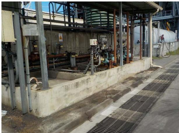
Photo 7 : Zone de dépotage de la cuve semi-enterrée de gasoil non routier
