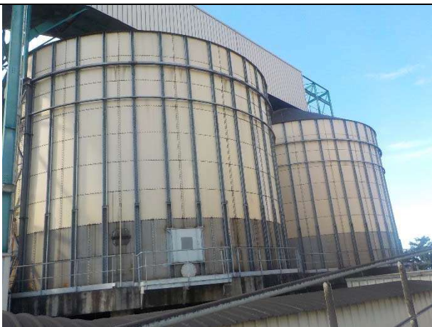
Photo 3 : Silos de charbon
