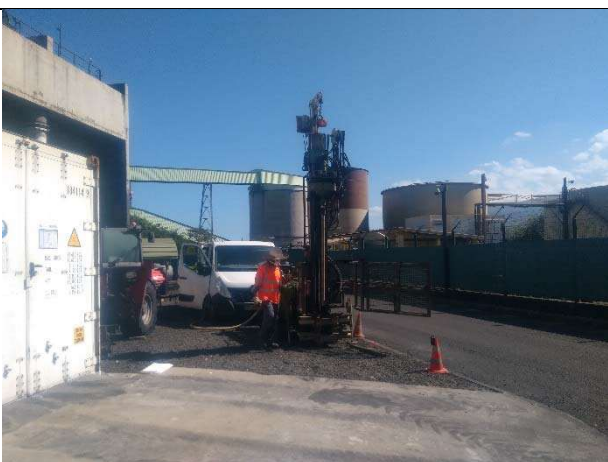
Photo 11 : Mise en station Pz1
