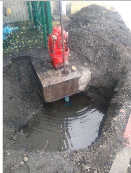
Photo 34 : Travaux sur le réseau incendi à 50 m au nord de Pz2
