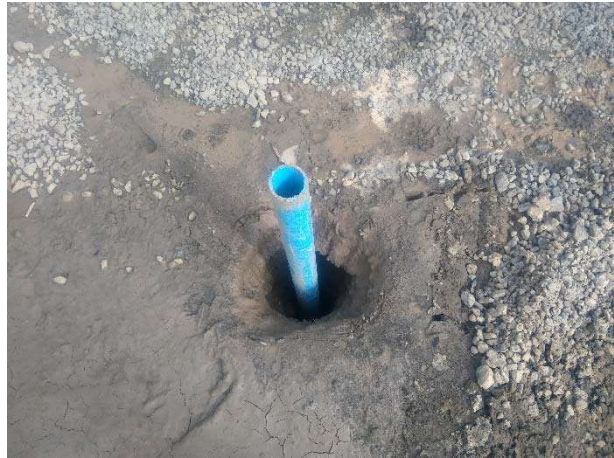
Photo 31 : Vue rapprochée Pz1 (Ouvrage temporaire non finalisé – margelle, capot – rebouché en fin de chantier)
