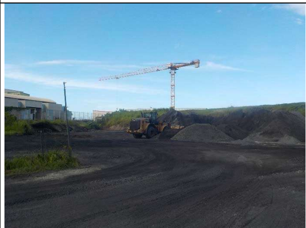
Photo 4 : Stockage de mélange des cendres volantes et scories à l'extérieur du site
