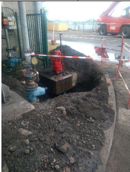
Photo 33 : Travaux sur le réseau incendi à 50 m au nord de Pz2
