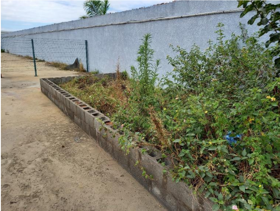
4 : Séparateur hydrocarbures protégé par un mur en parpaings
