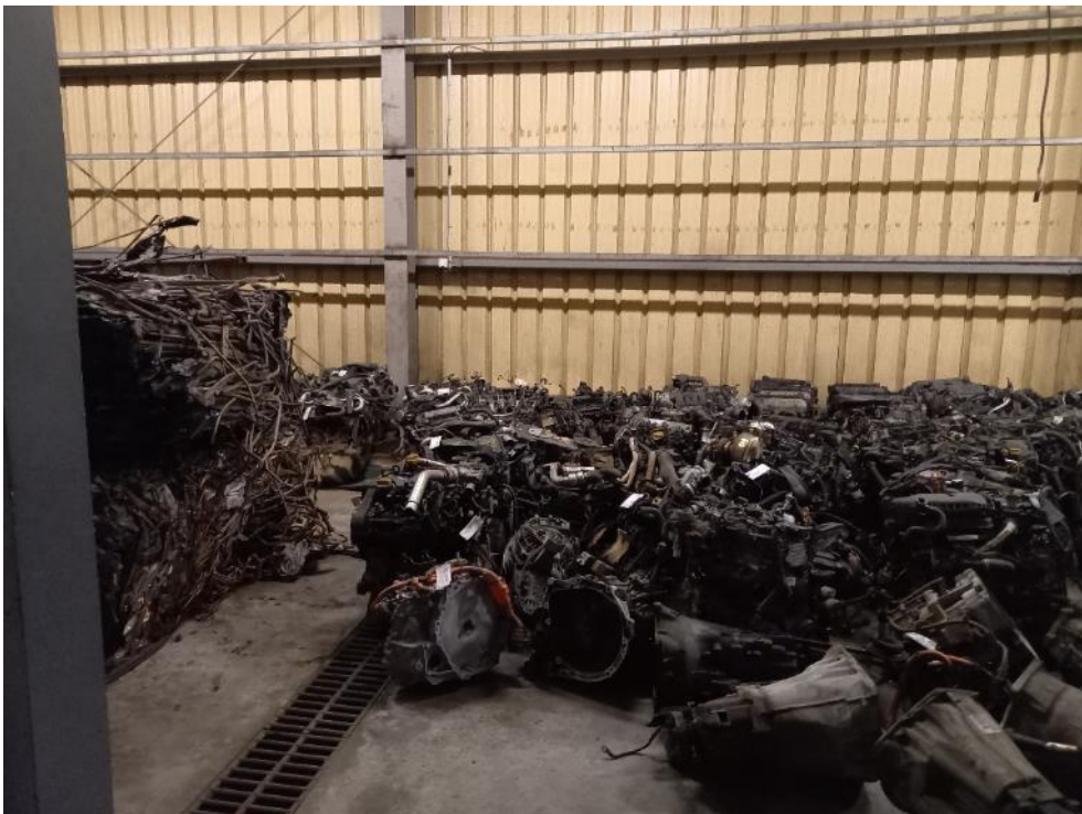
2 : Caniveau de récupération des EP dans l'atelier de démontage des moteurs
