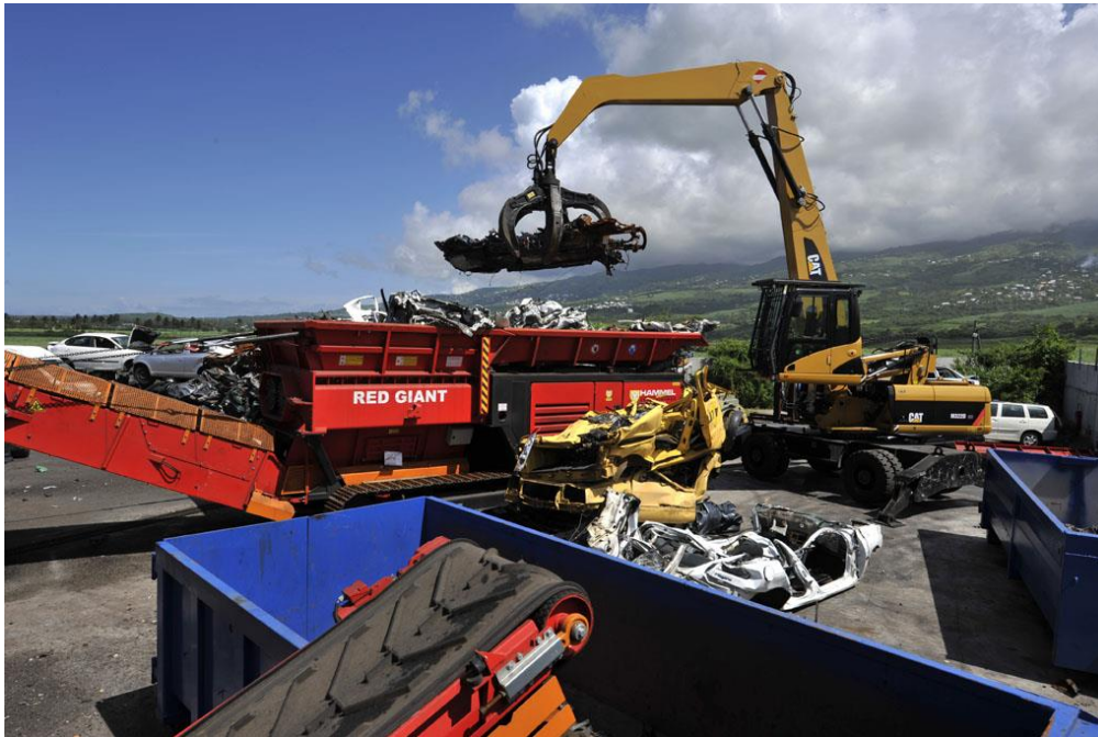
Figure 74: Chaîne de broyage sur le site de GENERAL AUTOS de Saint Louis
