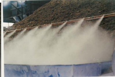
Traitement poussières compostage
