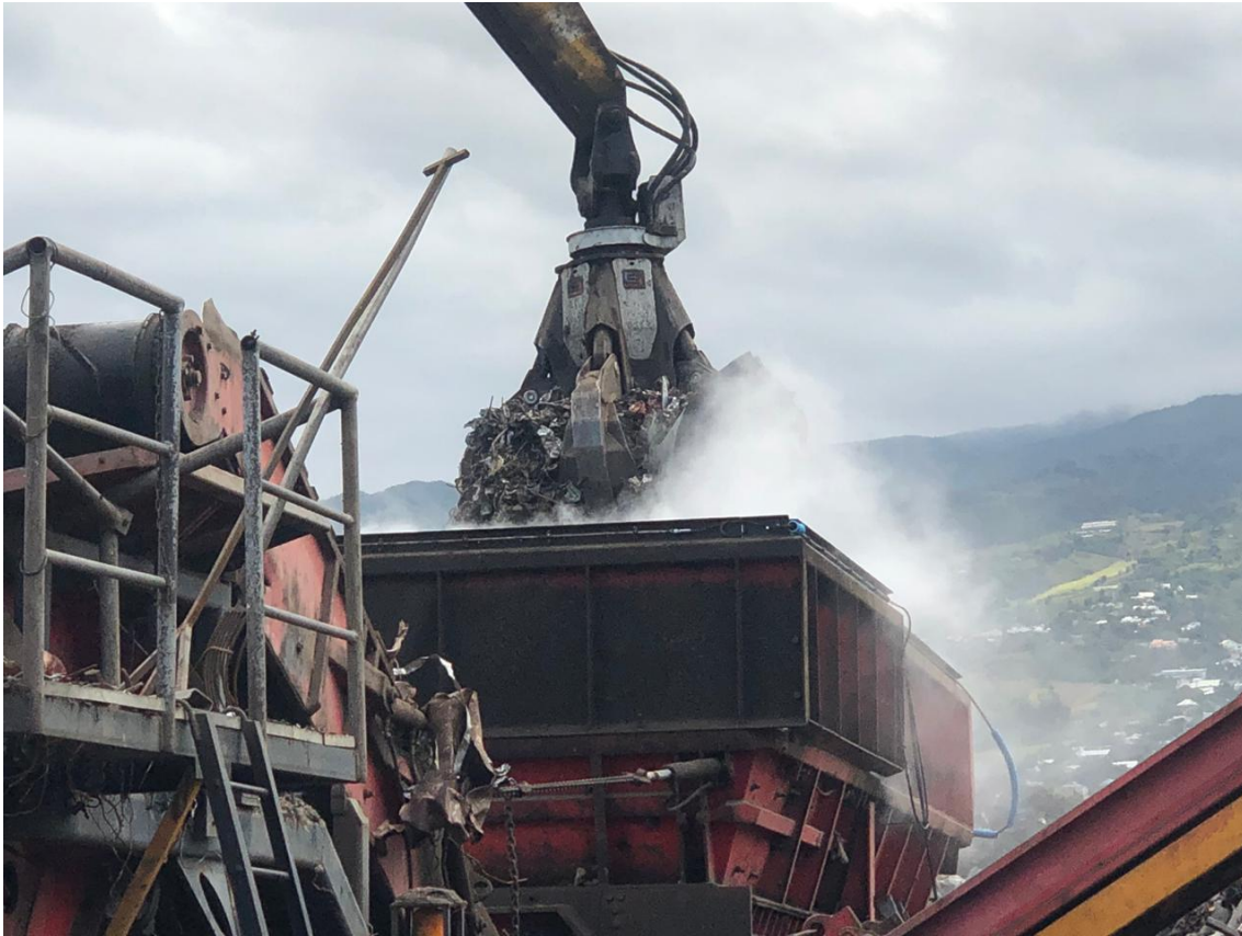
Figure 10: Nuage de brumisation au-dessus du broyeur en fonctionnement sur le site actuel
