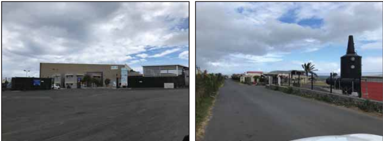
Planche 93 : Centre de tri des déchets ménagers (à gauche) et STEP Pierrefonds (à droite), Source : P. CRETIN
