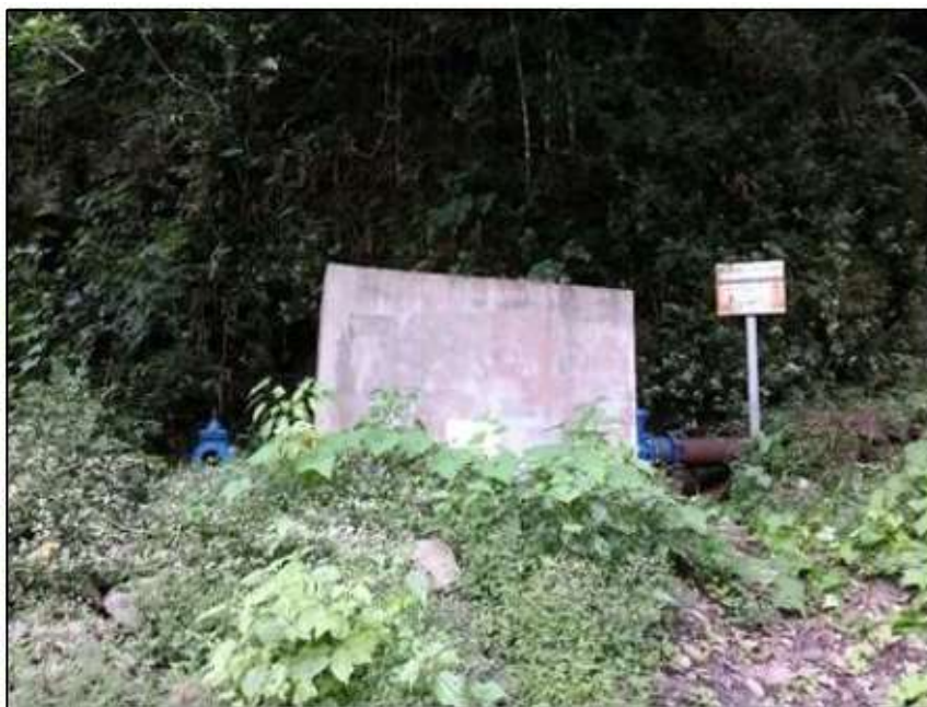
Regard en rive droite de la cressonnière & panneau signalant la présence du périmètre de protection du captage d'eau potable (posé en 2006)
