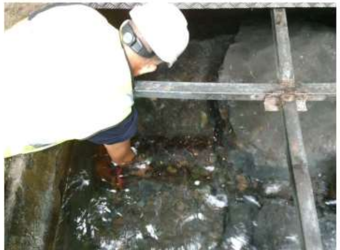
Nettoyage de la crépine du captage (feuilles, débris végétaux)
