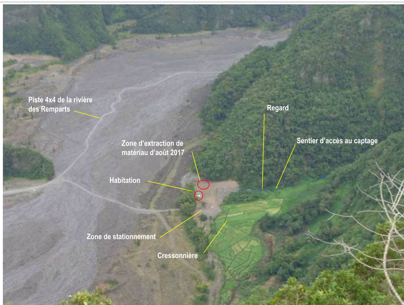
Environnement de la zone d'accès au captage depuis la rivière des Remparts (depuis le point de vue « le Serré »)
