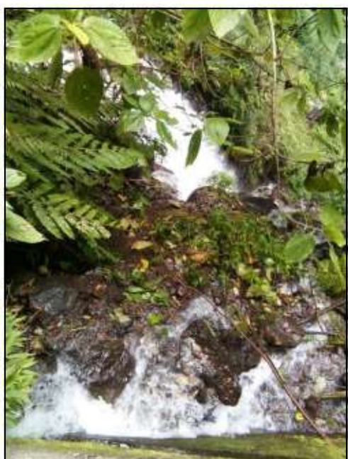
Rejet du trop-plein dans le rempart
