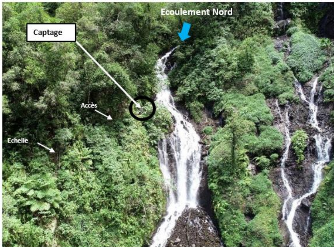
Photographie 4 : Vue du captage et de la cascade (Cliché Drone Tech 2019)
