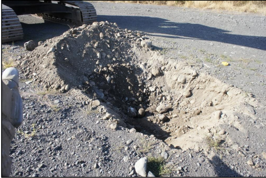
Vue de la fosse du prélèvement Pt n°1a
