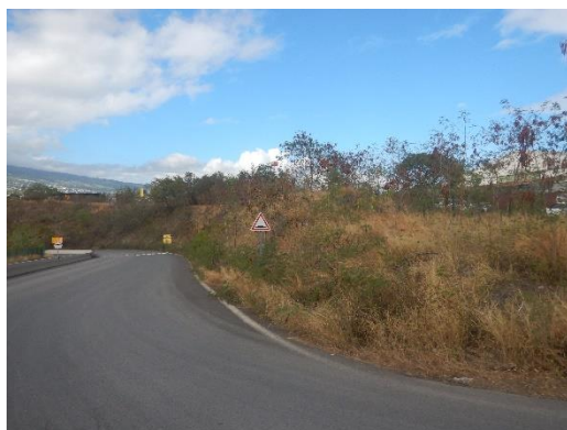
Buttes et voie d'accès à la zone de stockage
