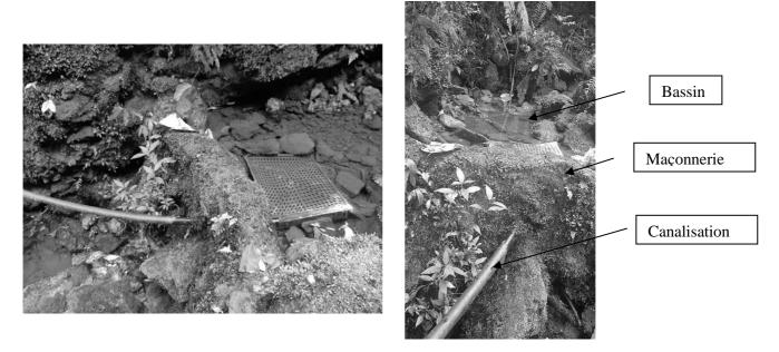
La maçonnerie date d'avant notre installation sur le domaine du relais (à l'époque où la zone était cultivée en géranium). C'est d'ailleurs parce qu'il y avait un ouvrage existant qu'on a décidé de faire le captage à ce niveau en 1991. En période d'étiage on observe plusieurs zones de résurgence dans le lit de la ravine. Hors période d'étiage le surplus passe au-dessus du bassin du captage et sur les côtés.
