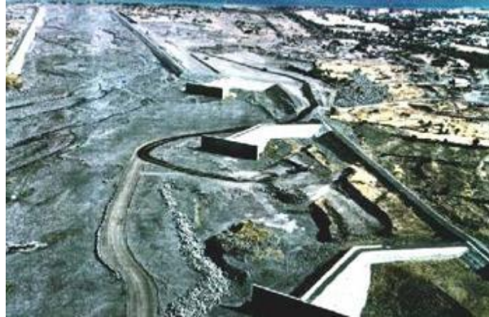
Figure 19 : Dignes en épis en rive droite de la rivière des Galets
