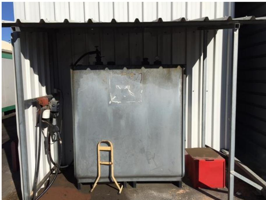
Figure 42 : Cuve aérienne de gasoil (1500 l)
