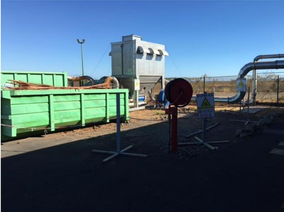
Figure 40 : Unité extérieure centralisée d'aspiration (silo à copeaux - zone ATEX)
