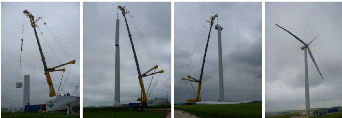
Fig. 20. Illustration de l'installation d'une éolienne
