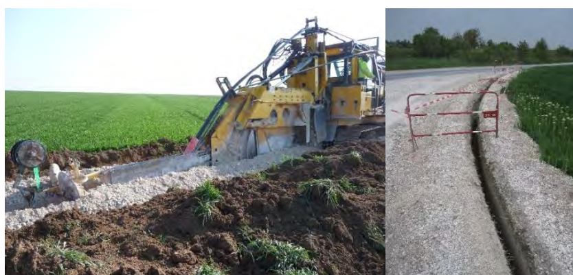
Fig. 7. Illustration d'une trancheuse en action et d'une tranchée (Source : Quadran).
