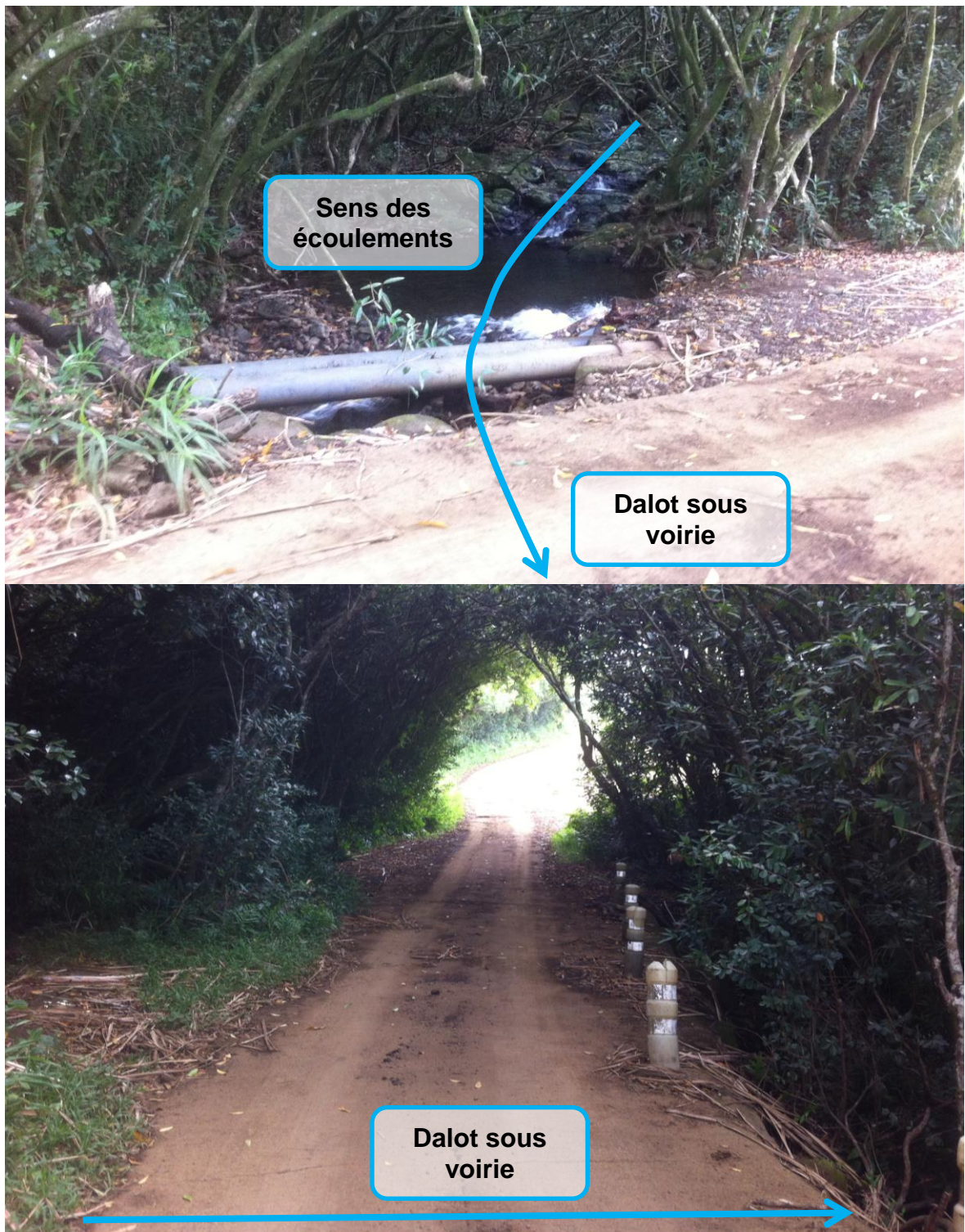
Photo.-4. Dalot sous voirie actuellement présent
