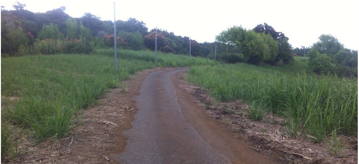
Photo.-3. Chemin d'accès actuel des éoliennes
