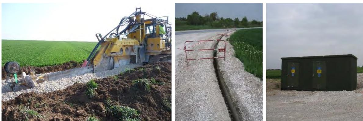
Illustration d'une trancheuse en action, d'une tranchée et d'un poste de livraison (Source : Quadran).
