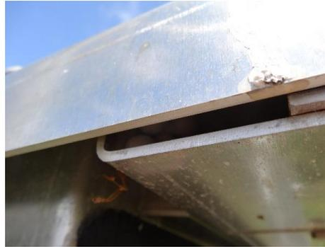
Figure 20 : Ponte entre les tôles dans le débord de toit sur la face avant de l'armoire technique
