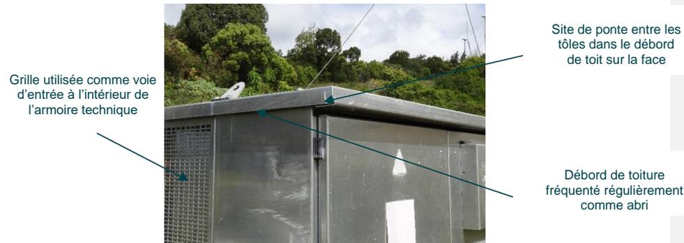
Site de ponte entre les tôles dans le débord de toit sur la face
