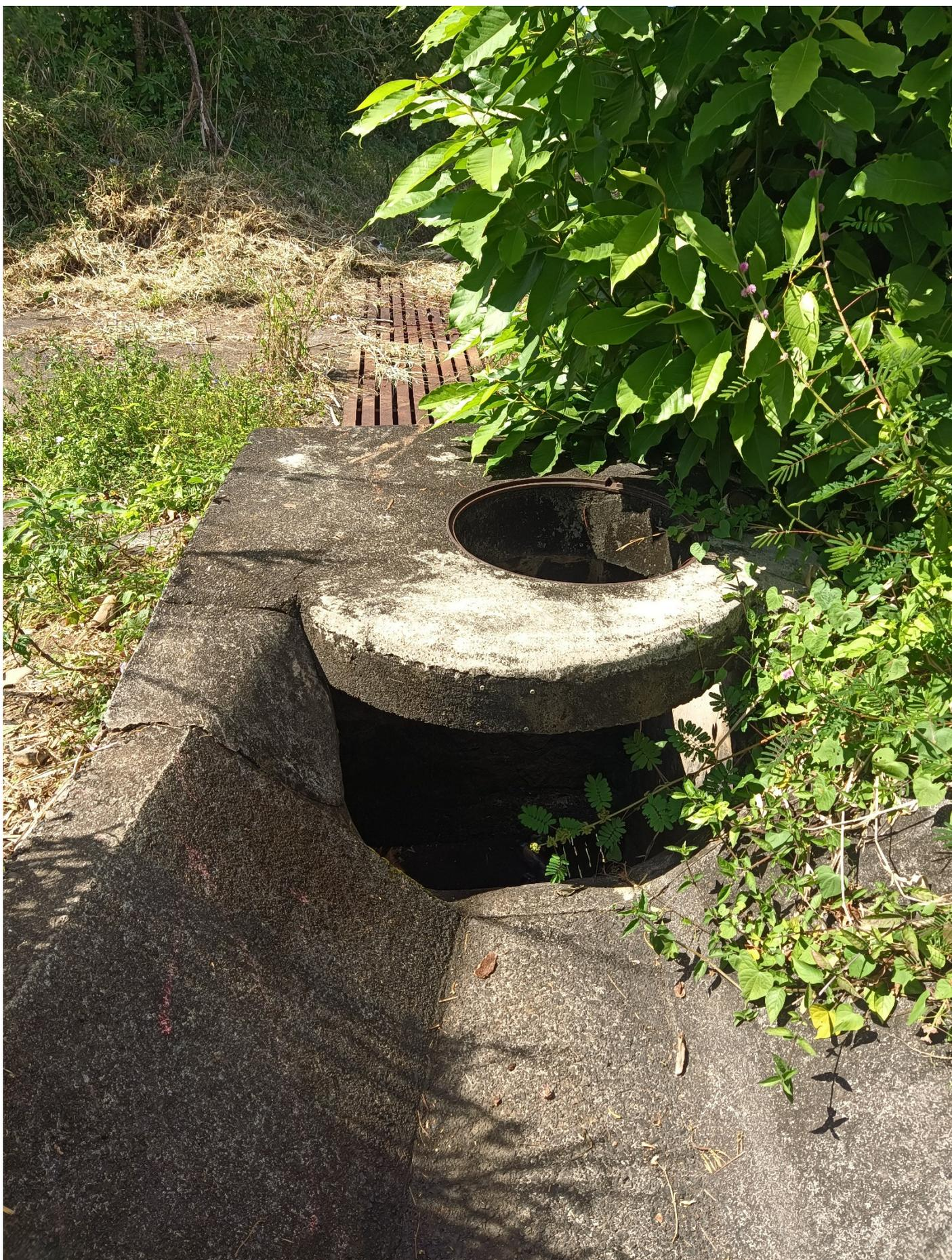
Figure 24 : Photo 3, regard récupérant le fossé Sud-Ouest et la buse béton placé dans les remblais derrière le passage cadre (buse récupérant le fossé Nord-Est de la RN2)
