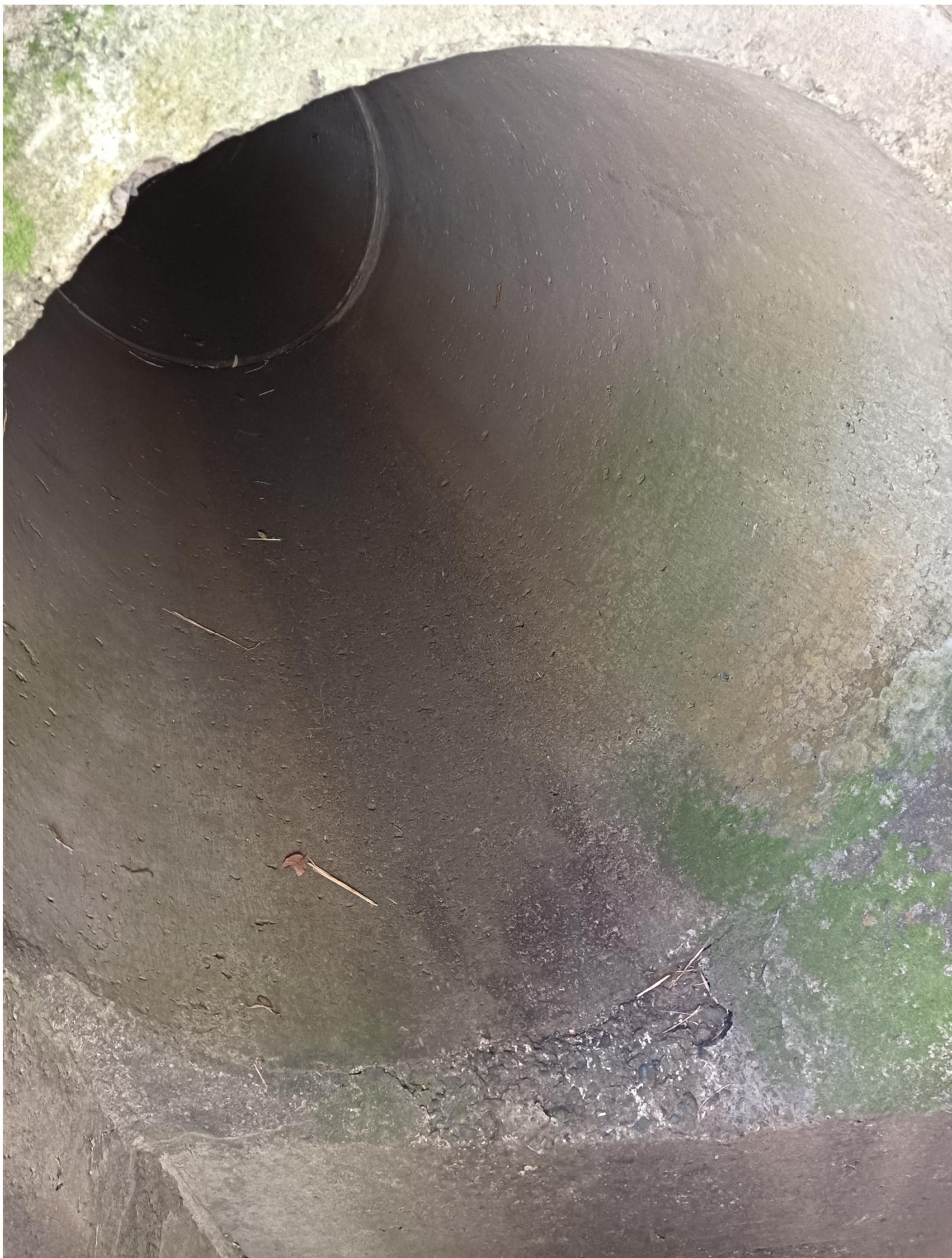
Figure 25 : Photo 3bis, débouché de la buse béton 1000 mm de diamètre dans le regard récupérant le fossé Sud-Ouest et la buse béton placé dans les remblais derrière le passage cadre (buse récupérant le fossé Nord-Est de la RN2)
