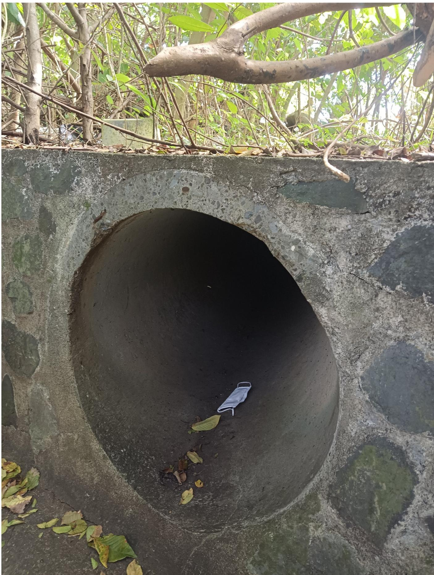
Figure 23 : Photo 2, buse béton après la traversée du chemin CFR, aboutissant dans le fossé Nord Est de la RN2
