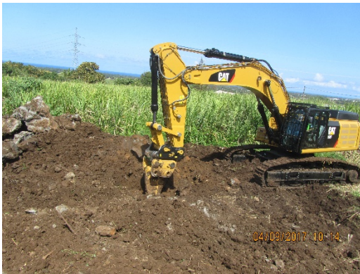
Épierrage de surface à la dent de déroctage et godet squelette
