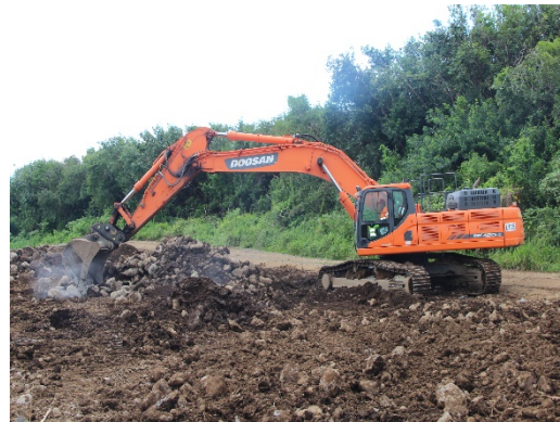
Épierrage de surface à la dent de déroctage et godet squelette
