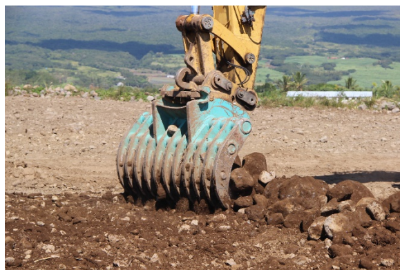
Étalement des stériles au bull avec Rockland et finition (ratissage) à la pelle avec un râteau
