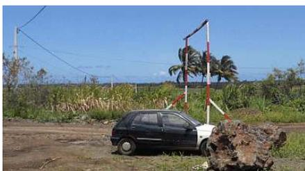
Installer des gabarits en entrée de zone de chantier soumise au risque électrique pour prévenir du risque et éviter l'entrée dans la zone d'engin hors gabarit.
