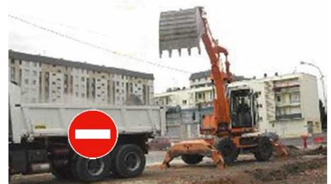
Gare aux piges, mètres, tubes, tuyaux, armatures, échafaudages, ... et autres outils et matériels linéaires ou de grande hauteur / longueur pouvant pénétrer par inattention dans la zone définie par la distance de sécurité.
