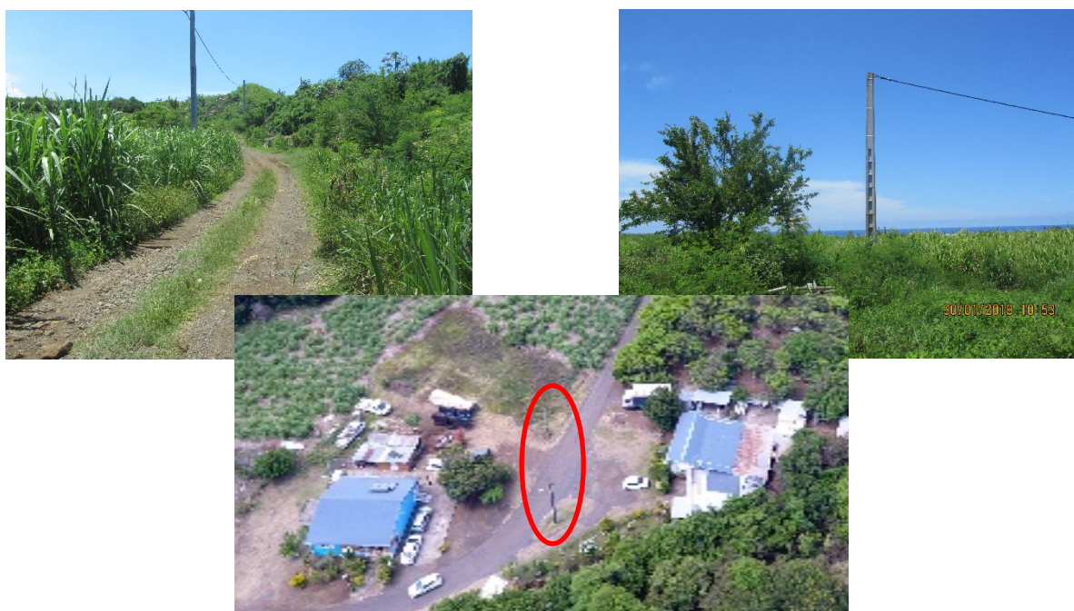
Ligne aérienne sur la parcelle DK 87 (Hors projet)
