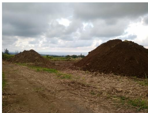
Exemple : phase 1 d'un chantier de réaménagement et d'épierrage d'un terrain : Arrachage des vieilles cannes et récupération de la terre végétale
