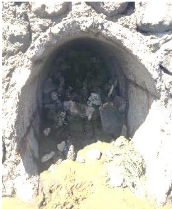
Exutoire visible mais section bouchée par le sable et les pierres charriés par la mer
