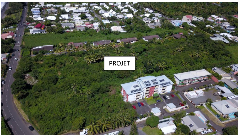
Figure 2 : Repérage photos (Source : KHEOPS DEVELOPPEMENT, 2022)
