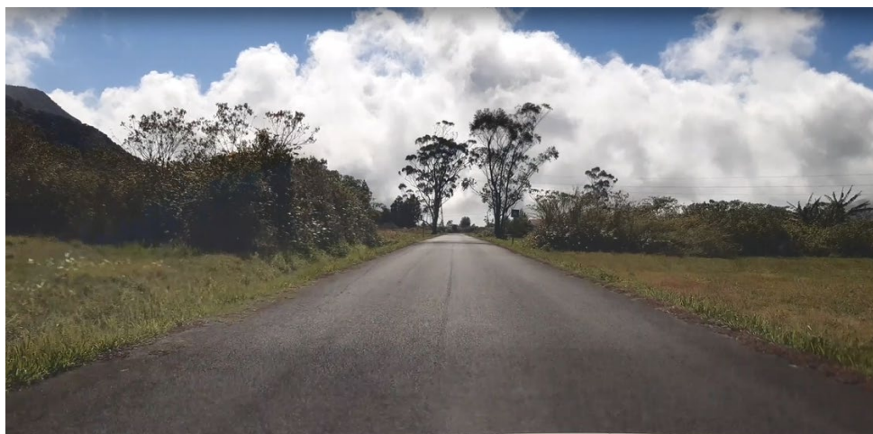
Figure 23: Voirie entourée de terrains agricoles et présence de fossés
