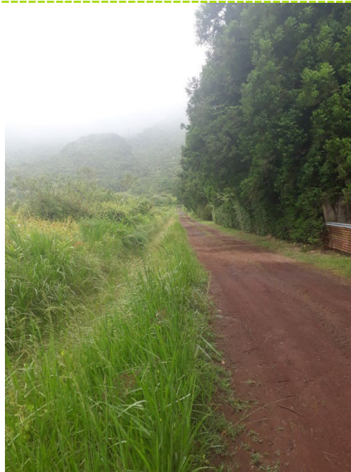
Figure 55: Fossé en amont du BV Arum 5
