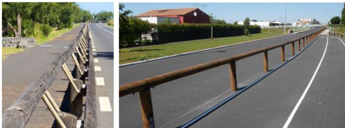
Figure 11 : Dispositif de retenue : Garde-corps bande cyclable (image de référence)
