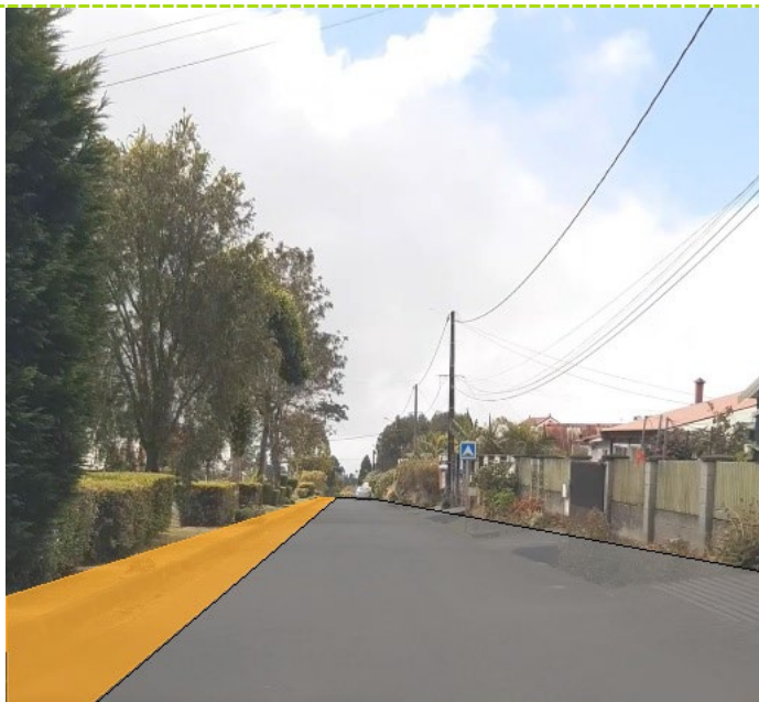
Figure 10 : voirie rue des Eucalyptus
