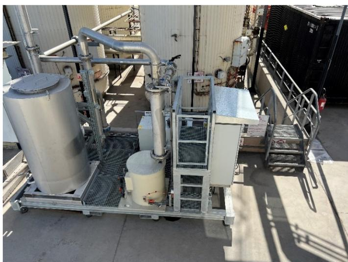
*Visuel de la station de traitement installée et de la connexion des 4 cuves de bitume du parc à liants*
